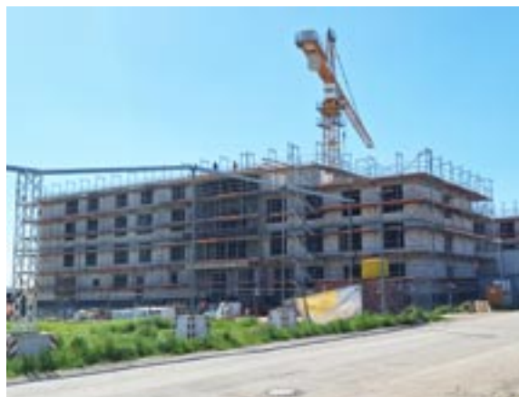
Richtfest an Kempens größter Baustelle. Im Spätherbst sollen die ersten 120 Bewohner einziehen.
