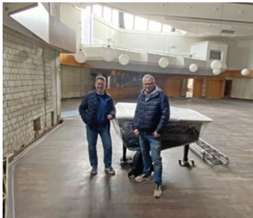
Stefan Schumeckers (l.) und Alfred Brinkmann nach Ende der Abbrucharbeiten im Saal der Albert-Mooren-Halle.
